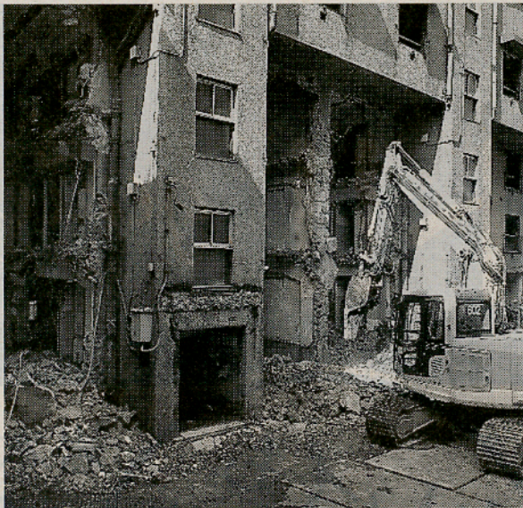
本格的な取り壊しが始まった同潤会上野下アパート＝17日午後、台東区、矢木隆晴撮影
